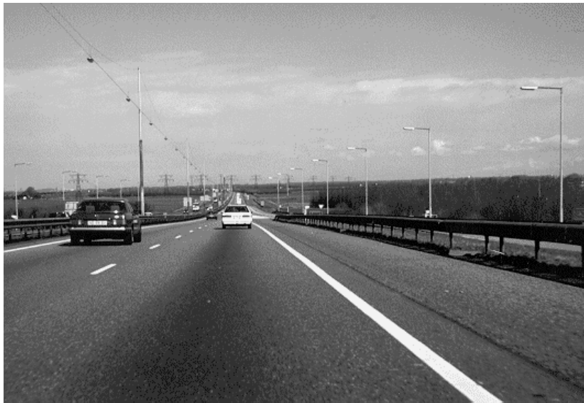
Afbeelding 138: Lijnverlichting op (hoofdrijbaan) + Mastverlichting op (verbindingsweg).
