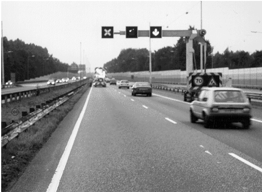
Afbeelding 119: Voorziening bij Werk in Uitvoering.
