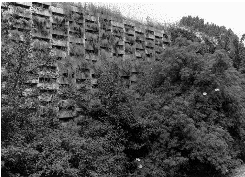
Afbeelding 28: Geluidswal als stapel constructie.
