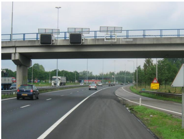
Afbeelding 98: Verkeerssignalering aan een viaduct.
